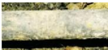
Asbestos Mains
